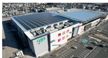
イーアス春日井 (発電容量：824.76kW)
