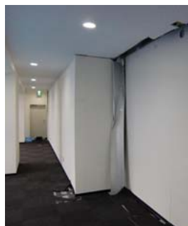
改修前(6階部分)
