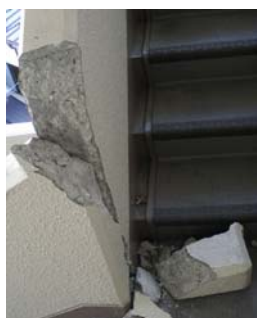
外部階段手摺(4階部分)
