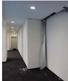
改修前(6階部分)
