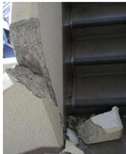
外部階段手摺(4階部分)
