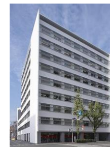
A53 KDX博多南ビル
