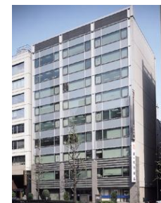
A1 KDX日本橋313ビル
