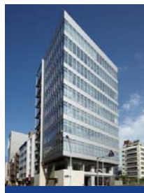
KDX日本橋216ビル
