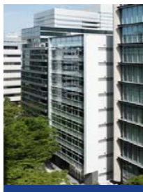
KDX新横浜381ビル増築棟
