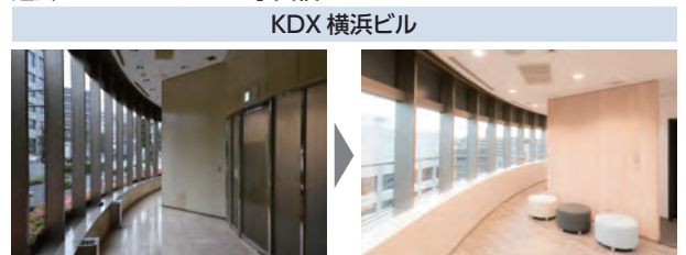
工事前(喫煙所)
