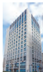
KDX横浜関内ビル
