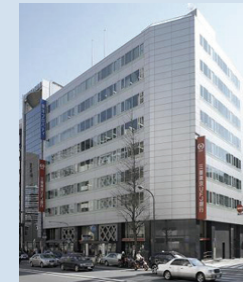
虎ノ門東洋ビル
