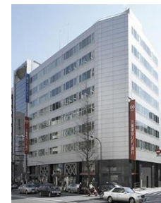
A40 虎ノ門東洋ビル
