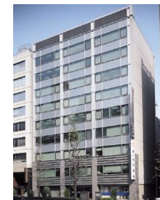
A1 KDX日本橋313ビル
