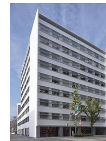
A53 KDX博多南ビル
