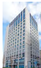
KDX横浜関内ビル
