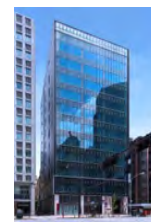
KDX新橋駅前ビル
