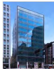
KDX新橋駅前ビル
