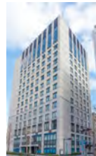
KDX横浜関内ビル
