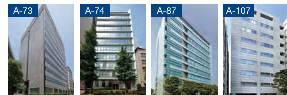
KDX箱崎ビル A-73 KDX新日本橋ビル A-74 イトーピア日本橋SAビル A-87 KDX銀座イーストビル A-107
