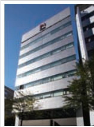
④ 日総第17ビル Nissou Dai-17 Building
