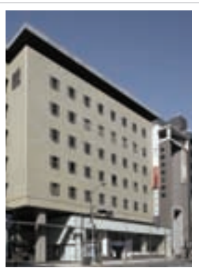
A-42 烏丸ビル Karasuma Building
