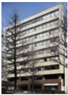
A-44 KDX仙台ビル KDX Sendai Building
