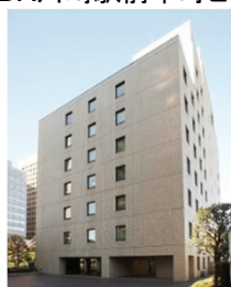
KDX川崎駅前本町ビル
