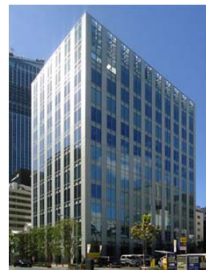
KDX Toranomon 1chome Bldg.
