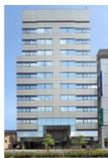
KDX Mita Bldg.
