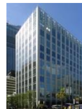
KDX Toranomom 1chome Bldg.
