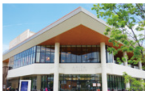
アピタテラス横浜綱島 (発電容量:25.26kW)
