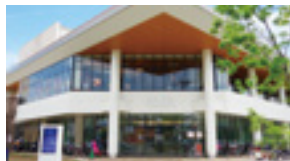
アピタテラス横浜綱島 (発電容量:25.26kW)
