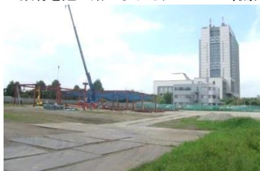
2.鉄骨を建て始めました(2015/8/22撮影)
