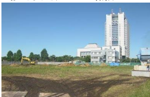
1.着工しました(2015/6/20撮影)
