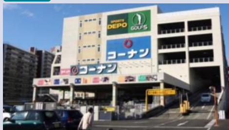
ホームセンターコーナン砂田橋店 所在地: 愛知県名古屋
