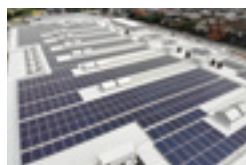
かわまち矢作モール (発電容量:302.40kW)
