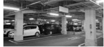
棟内駐車場 (地下1階、3階、屋上)
