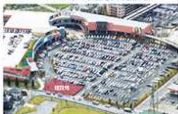
ユニクス伊奈の航空写真(建設地)
